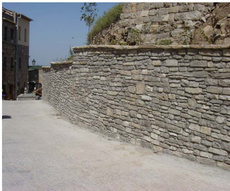
Obres de rehabilitació del nucli de Montoliu de Segarra
