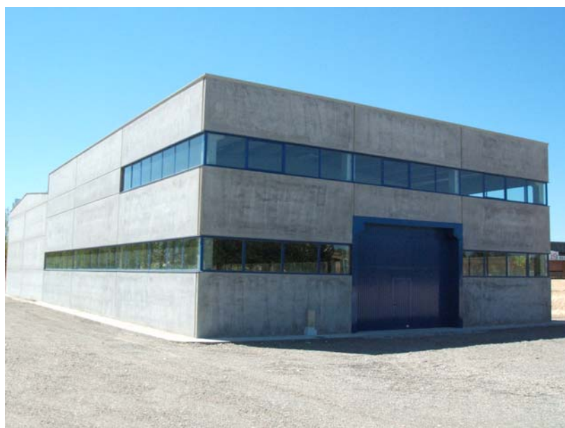
Noves instal·lacions per al Parc Mòbil. Caparrella
